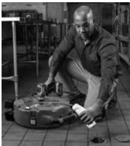
Abbildung 13 – Auftragen von Schmiermittel auf die Spiraleummantelung
