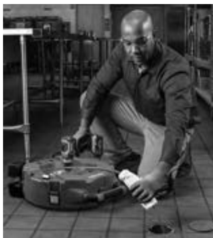
図 13 – ケーブルシースへの潤滑油の塗布
